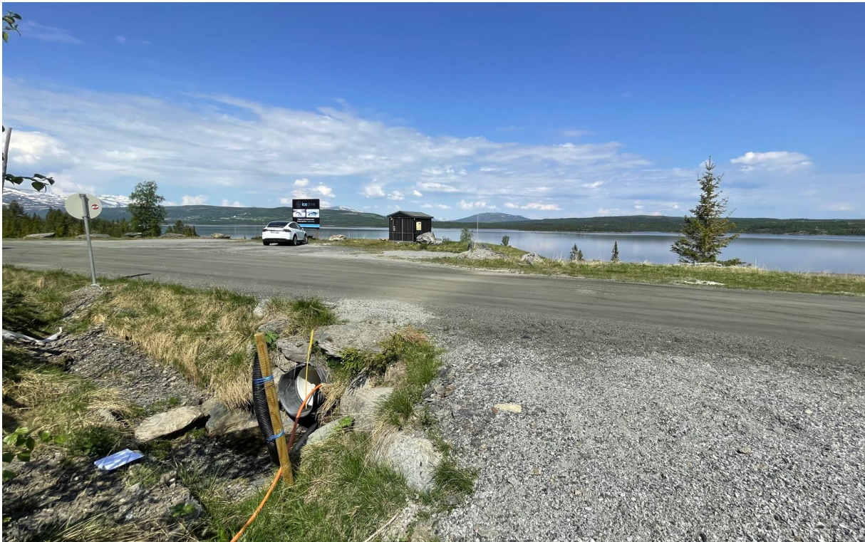
Figur 5: Auenhauglivegen med stikkrenne knyttet til vurdert bekk. Flomvei vurdert mot vest (venstre i bilde) og over vei.
