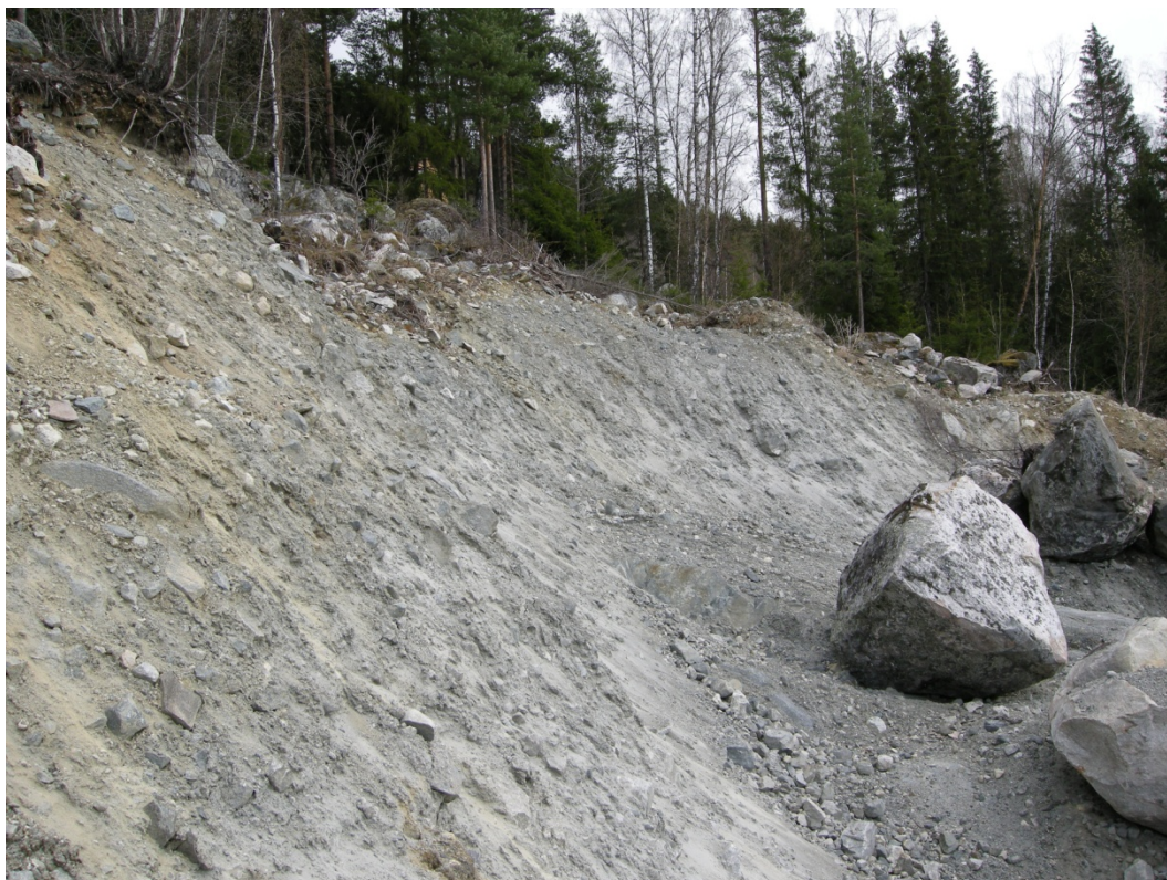
Figur 3: Utgraving i den sørøstlige delen av det vurderte området, omtrent der den planlagte veg skal slutte. De opprinnelige massene består av morene med en mektighet på antakelig 3-5 m, over lite oppsprukket fjell.
