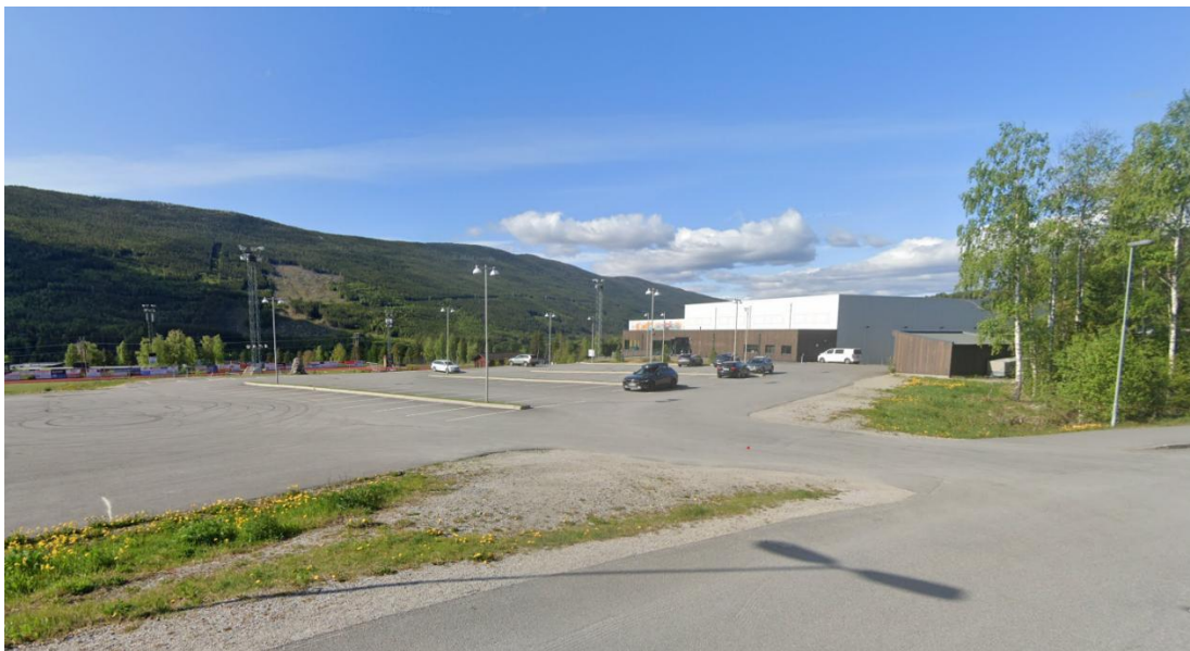
Flerbrukshallen med parkeringsarealer (Google Maps)
