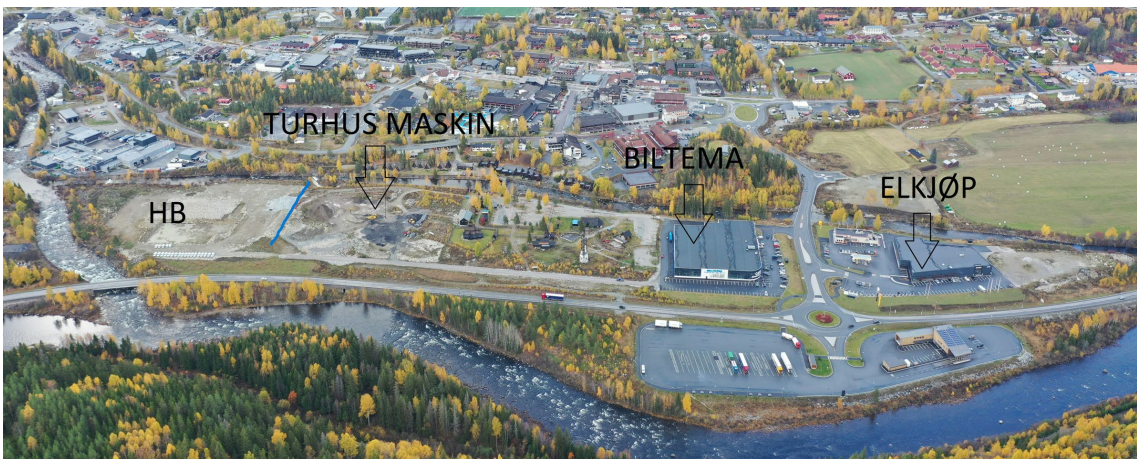
Figur 3 Dronefoto 2022. Med plassering av eksisterende og planlagt utbygging (HB er Hallingdal bilsenter). Foto: Turhus maskin
