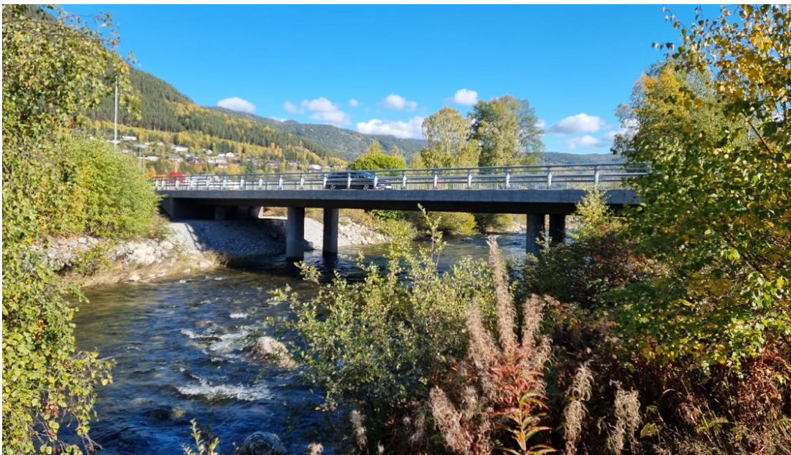
Figur 20 Hahaugvegen bru. Sett fra oppstrøms side.
