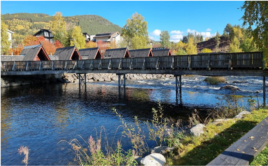
Figur 21 Gangbru over Vesleåna. Sett fra oppstrøms side.
