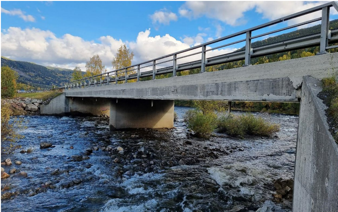
Figur 23 Vikø bru. Sett fra oppstrøms side.
