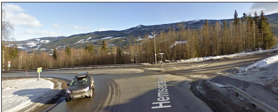
Figur 22 - Krysset rv. 52 X fv. 223 Tuppeskogvegen sett fra nord (maps.google.no)
