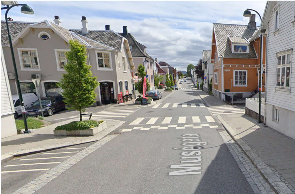
Figur 5-5. Muségata i Stavanger med visuell innsnevring (gatestein langs kantene) og opphøyd krysningspunkt. Kilde: Google maps, streetview.
