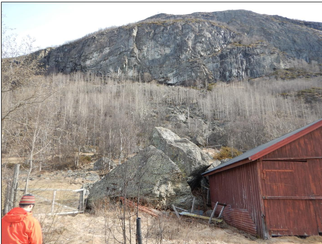
Figur 17: Garasje i foten av et gammelt steinskred. Ved Vøllo, bilde tatt mot nordøst.
