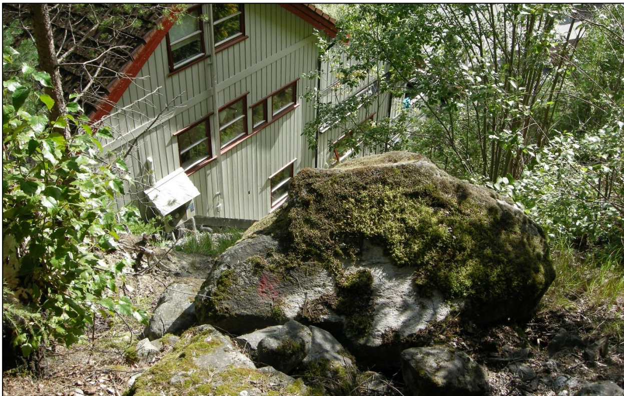
Figur 38: Løsmasseskråning og blokk ovenfor bebyggelsen i Nøbbelie 29.
