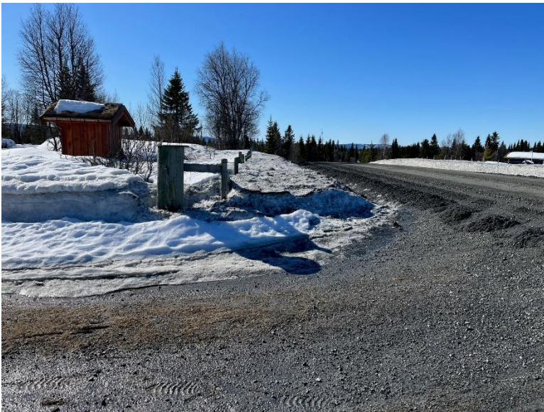
Figur 8. Bilde av eksisterende avkjørsel sett mot sør. Denne vil bli forskjøvet og hevet. Samtidig vil gjerdet bli flyttet så en bil kan stå i avkjørselen på yttersiden av gjerdet.
