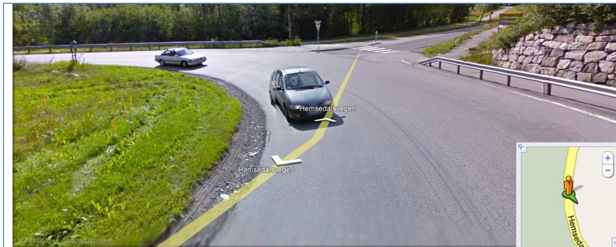
Kryss RV 52 og Tuppeskogvegen.
