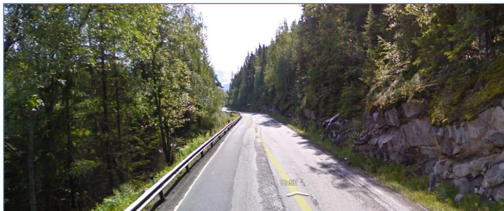
RV 52 mangler g/s-veg på deler av strekningen mellom Spildra og Bygdheim.
