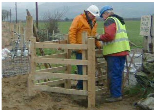
Figur 12: Til venstre gjerdeklyvar med handtak og til høgre sauesikker grind, Foto Erling Skurdal
