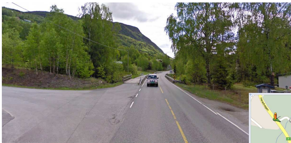
Smal bru på RV 7, autovern på bru hindrer frisikt fra Narvebrøten.
