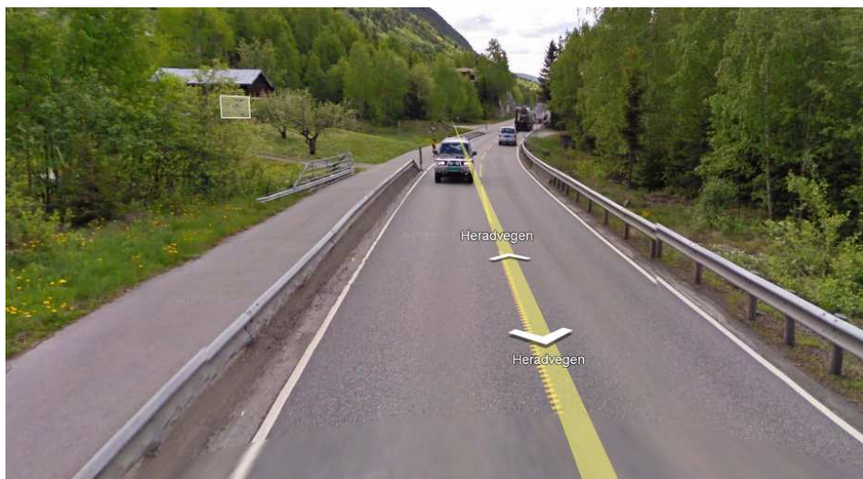
Gang/sykkelveg mangler lys fra Narvebrøten til Plassen
